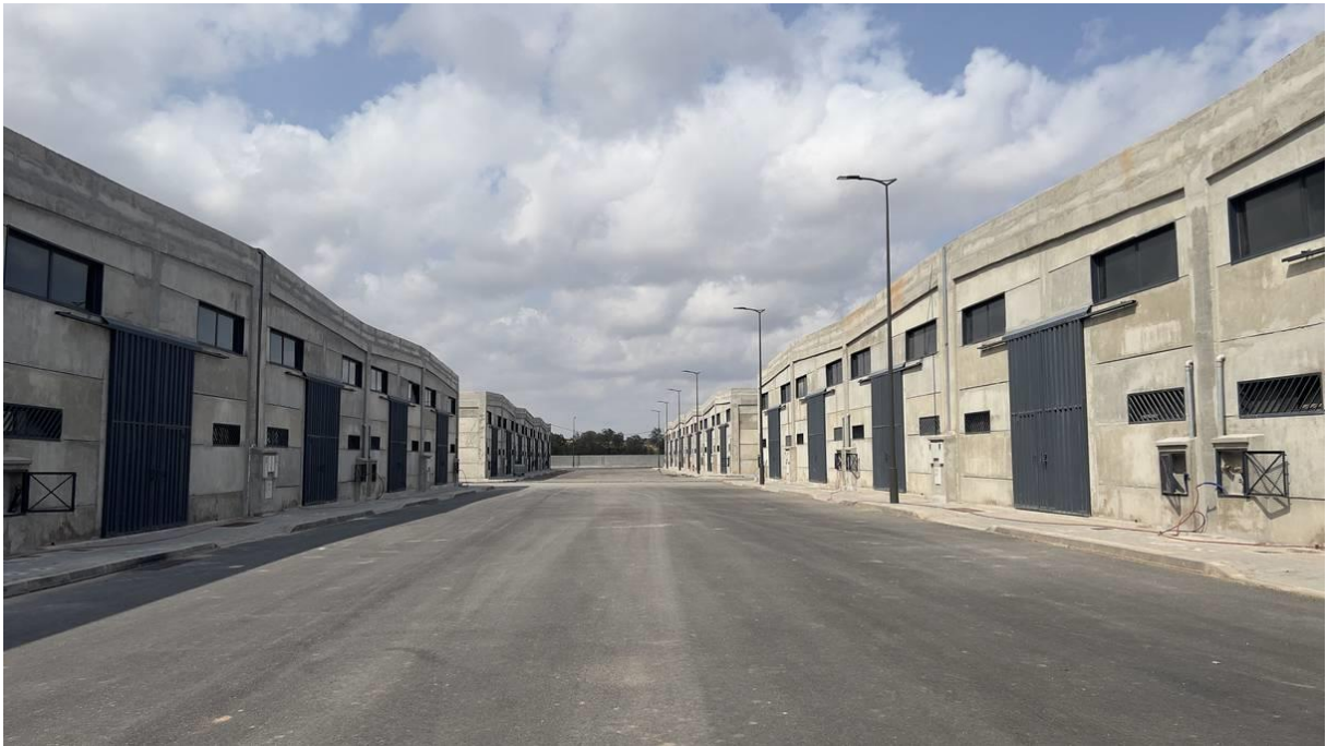
La nouvelle zone d'activité économique (ZAE) d'Ouled Azouz, dans la province de Nouaceur.
